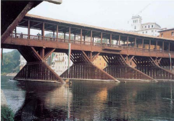
α. Γέφυρα ξύλινη
