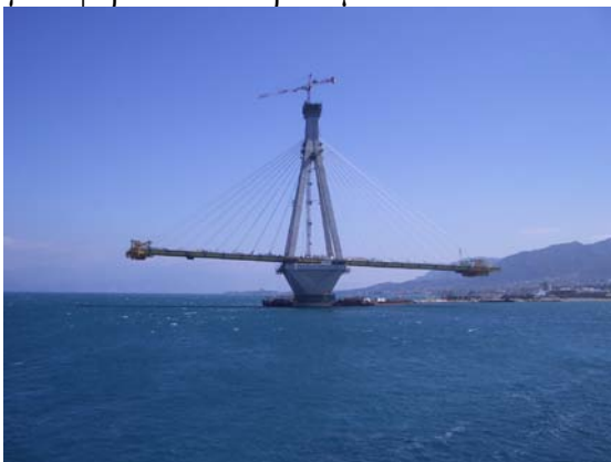
ε. Γέφυρα σύμμικτη
