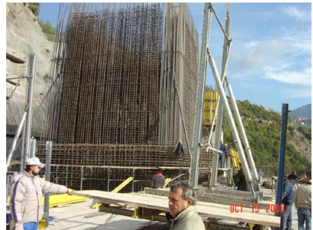
Οπλισμός κεφαλόδεσμου – βάσης μεσοβάθρου
