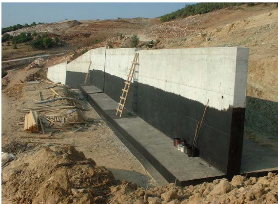
Σχήμα 1.5 - Τυπικός τοίχος αντιστήριξης
