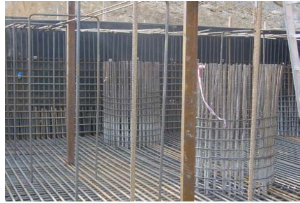
δ. Πάσσαλοι – κεφαλόδεσμος
