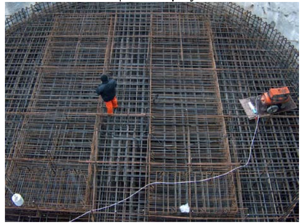
στ. Οπλισμός μεσοβάθρου
