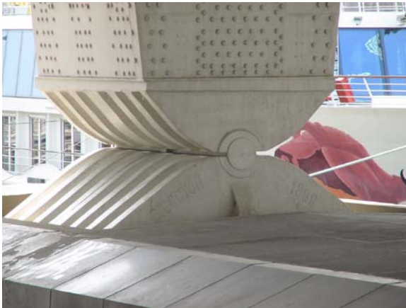
Σχήμα 1.16 – Αρθρωτά εφέδρανα
