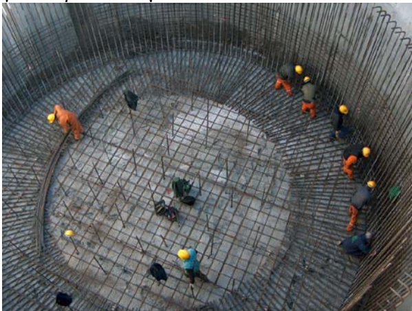
ε. Οπλισμός φρέατος θεμελίωσης μεσοβάθρου
