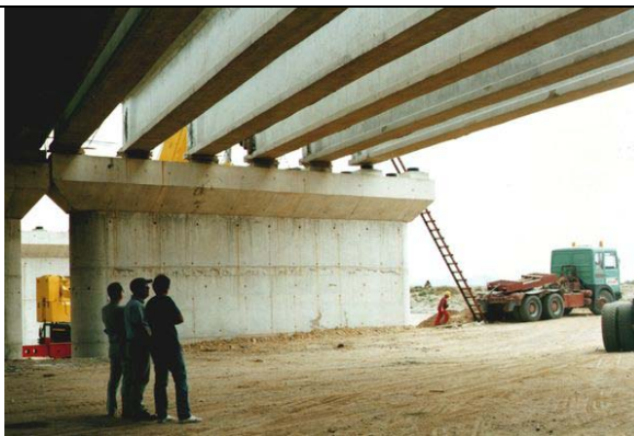
δ. Μέθοδος προκατασκευασμένων δοκών
