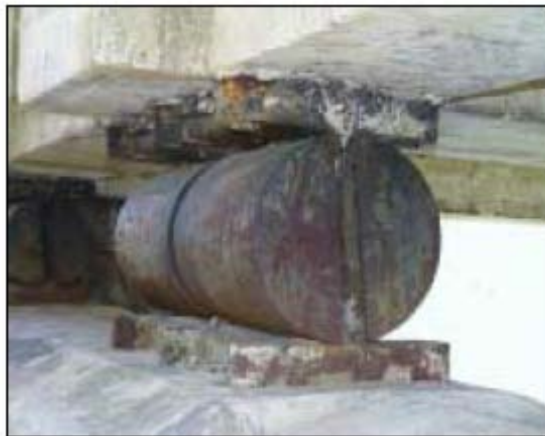
Σχήμα 1.17 – Κυλιόμενα εφέδρανα
