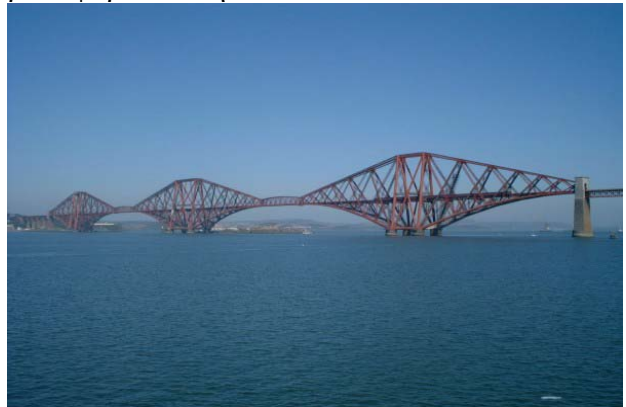
δ. Γέφυρα μεταλλική
