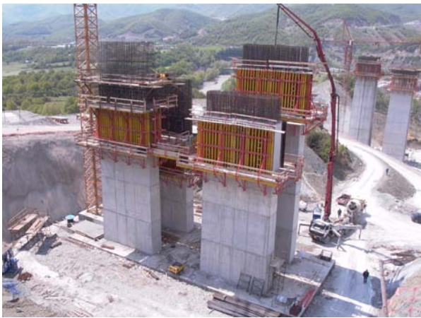
Κατασκευή μεσοβάθρου μορφής δίδυμων λεπίδων
