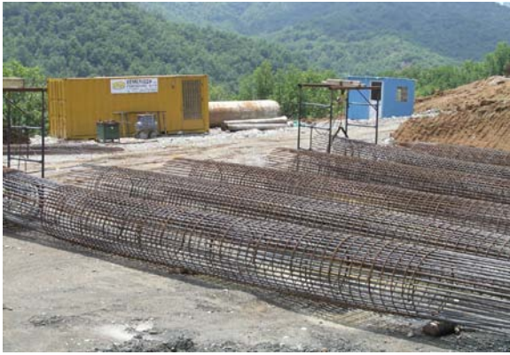
γ. Κλωβοί οπλισμών πασσάλων
