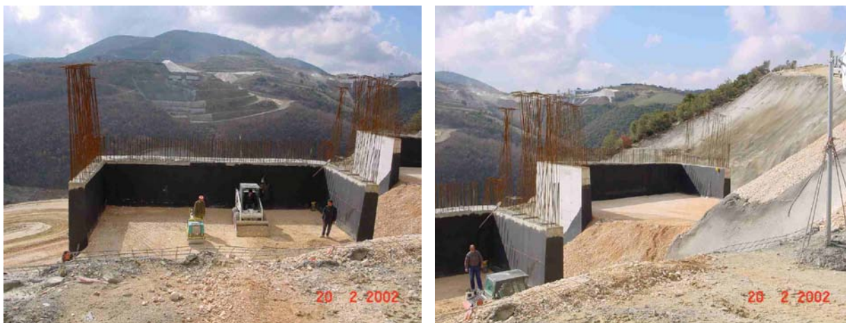
Σχήμα 1.11 – Κατασκευή μεταβατικού επιχώματος ακροβάθρων
