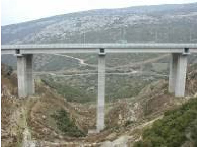
Εικόνα 2α. 2 η Χαραδρογέφυρα Καβάλας Γ2
