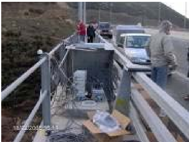
Εικόνες 1α, 1β. Εγκατάσταση δικτύου 12 κανάλων επιταχυνσιογράφων
