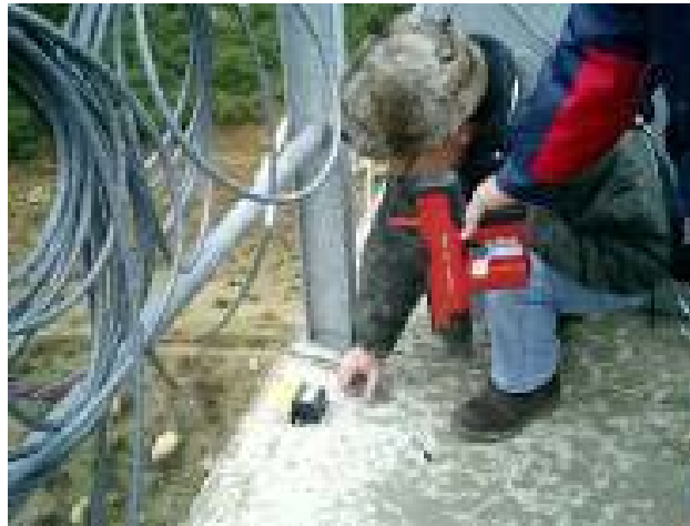
Εικόνες 1α, 1β. Εγκατάσταση δικτύου 12 κανάλων επιταχυνσιογράφων
