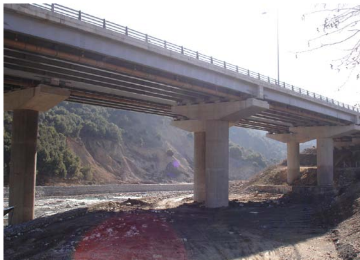
Φωτ. 6 Γέφυρα T10, τμήμα 2.4 της Εγνατίας οδού
