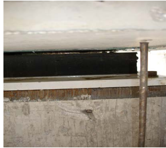
Φωτ. 2,3 Εφέδρανα της Γέφυρας T10
