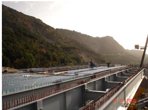
Φωτ. 5 Όψη Ρύγχους και Μεταλλικών Δοκαριών
