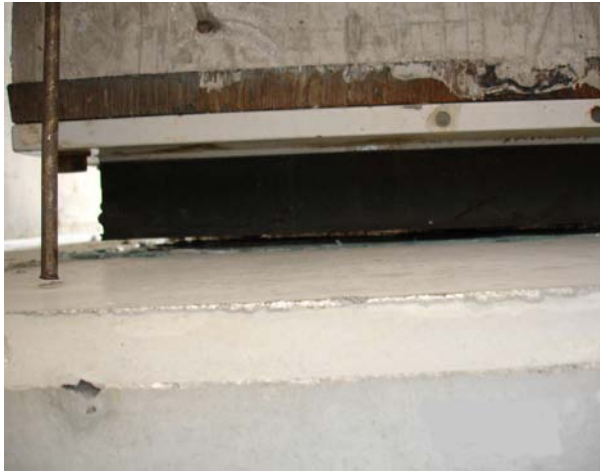
Φωτ. 2,3 Εφέδρανα της Γέφυρας T10
